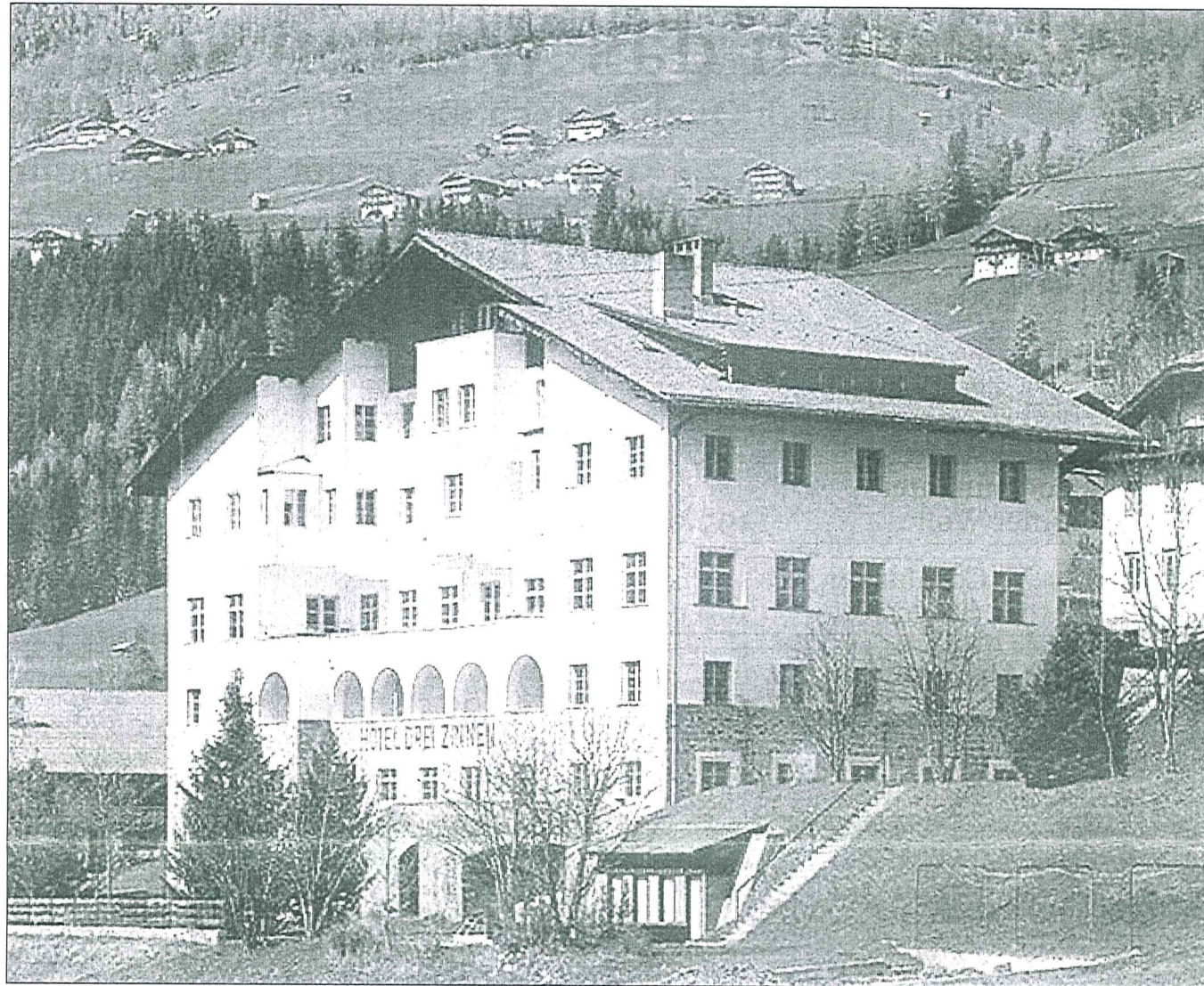
Ein altes Hotelgebäude von hoher Qualität, geplant von Prof. Clemens Holzmeister. Es fügt sich trotz der Größe gut in die Umgebung und die Landschaft ein. Qualitätsvolle Bauten sind immer zeitgemäß und zugleich zeitlos.
